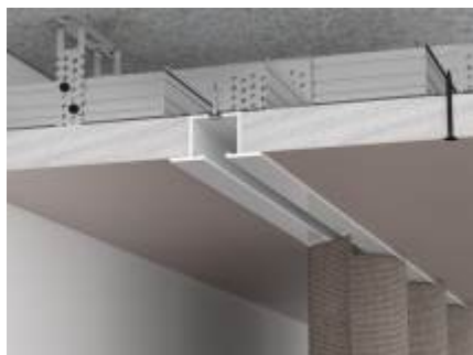
Montarea șinei în structura de rigips deja instalată.
